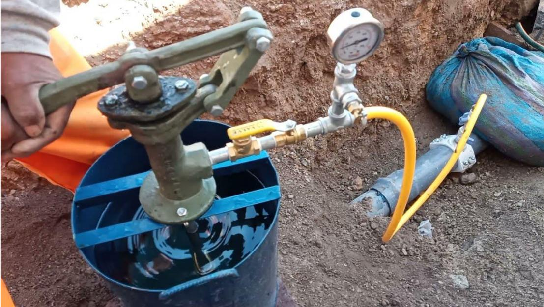
No se permitirá, ni autorizará realizar la prueba a zanja tapada con relleno compactado y desinfectado, si previamente la Supervisión no ha aprobado vía Bitácora la prueba a zanja abierta de la línea de agua.
