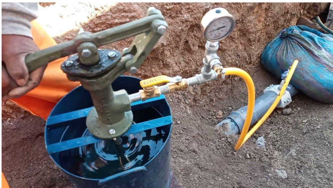
No se autorizará realizar la prueba a zanja tapada con relleno compactado y desinfectado, si previamente la Supervisión no ha aprobado vía cuaderno de bitácora la prueba a zanja abierta de la línea de agua.
